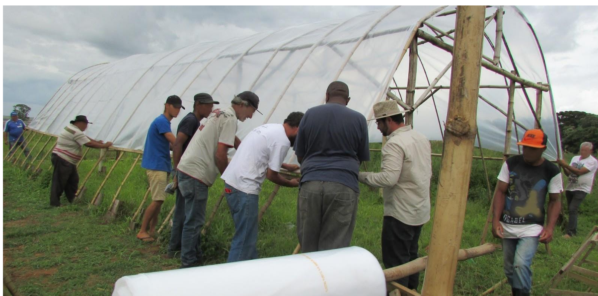
Figura 1 – Esticando a lona na estufa.
