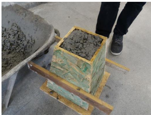
FIGURA 1 – CONFECÇÃO DO MARCO DE CONCRETO
