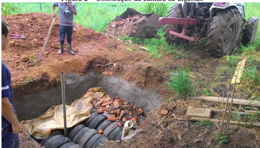
Colocação de pneus e entulhos no interior da estrutura impermeabilizada
