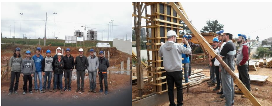
Figura 1 – Acadêmicos e professores no canteiro de obras da edificação do Núcleo de Práticas Jurídicas da UEPG
