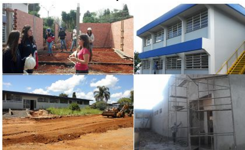
Figura 1 – Acadêmicos e professores no canteiro de obras – Obra do Bloco L e Obra do Bloco de E do Campus Uvaranas da UEPG
